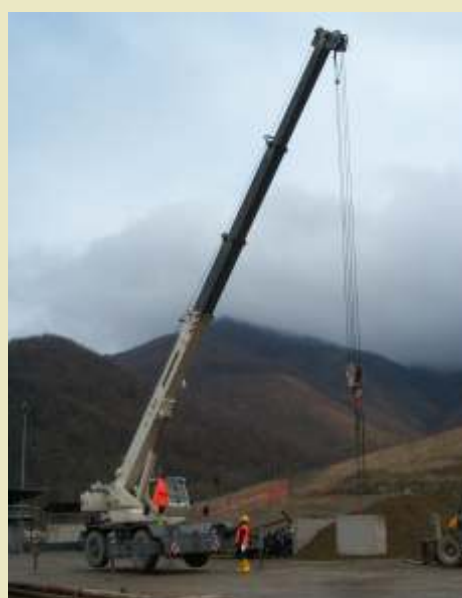
Autogrù gommata telescopica Controlli di efficienza dispositivi di sicurezza
