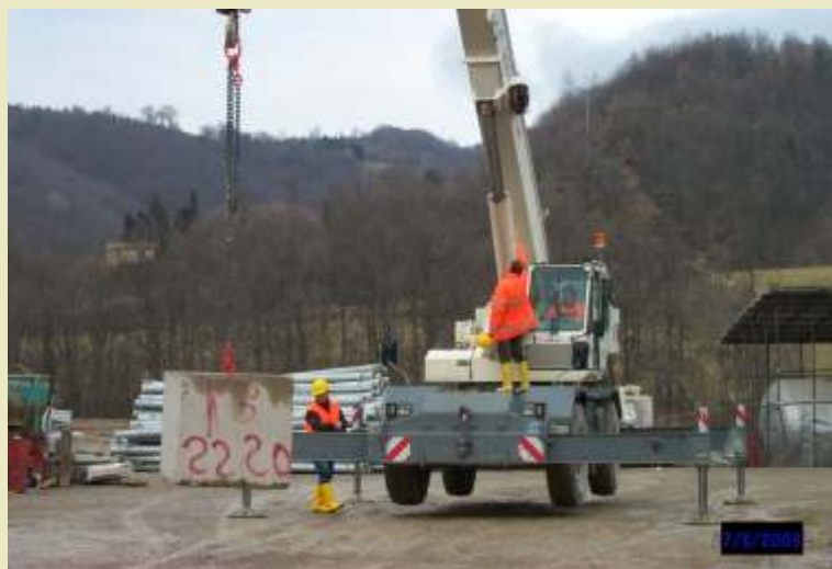
Autogrù gommata telescopica operazioni di controllo
