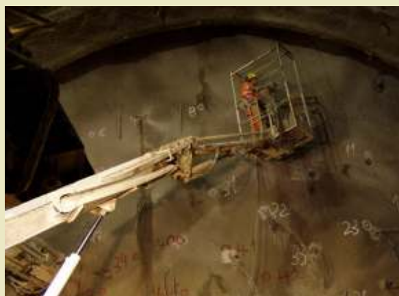
Operazioni al fronte di scavo con ausilio di P.L.E.
