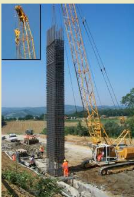
Autogrù cingolata con braccio ad elementi tralicciati e ad inclinazione variabile
