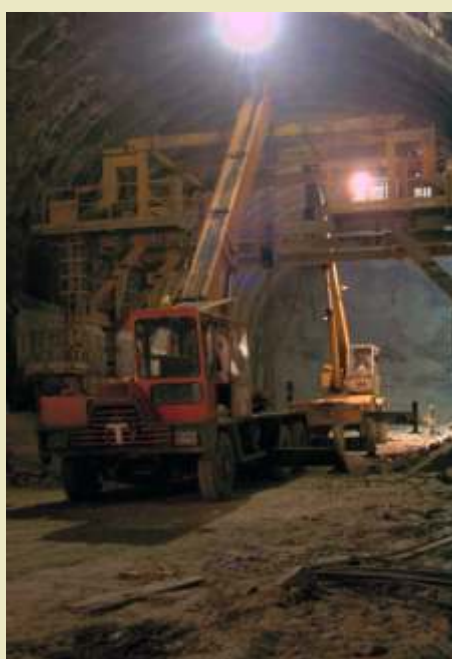
Apprestamenti per sollevamento multiplo mediante due autogrù a braccio telescopico
