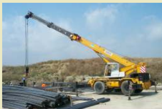
Autogrù gommata con braccio telescopico ad inclinazione variabile (stabilizzata per operazioni di sollevamento)
