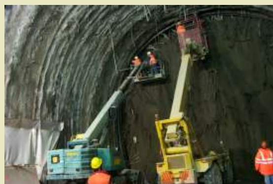
Posa in opera di centine con ausilio di P.L.E.
