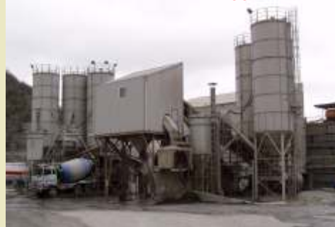
Foto 5: Impianto di betonaggio
