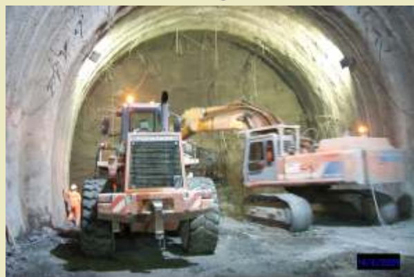
Foto 2: Escavatore e pala meccanica
